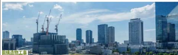
鋼構造物工事
